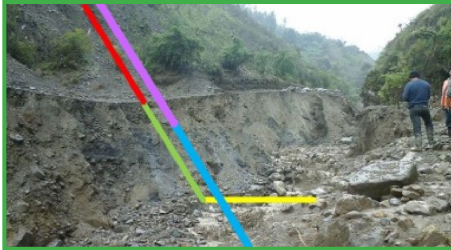
Ilustración 29: Segmentación de un torrente en su cauce (amarillo) y sus taludes correspondientes (talud del cauce = azul, ladera = violeta). Fuente: Río Taquiña, Los Tiempos
